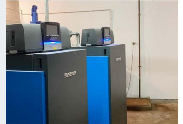
Bislang versorgten drei Gaskessel die beiden Liegenschaften in Tempelhof mit Wärmeenergie. In der Wirtschaftseinheit WIE 017 wurde die ineffiziente, defekte Gaskesselanlage bereits ausgebaut und eine neue energieeffizientere Anlage mit einem vorbereiteten Anschluss für eine Wärmepumpenanlage aufgestellt, die an das Versorgungsnetz gekoppelt wurde. Derzeit läuft zudem die Prüfung für eine Photovoltaikanlage auf dem Dach.
