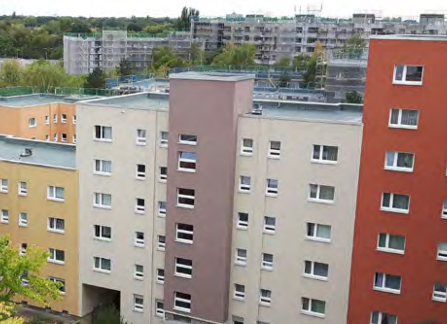
WA 32–35 (Ortolanburg): Energetische Sanierung
